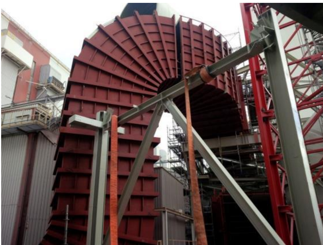
Prace budowlane dostawa/modernizacja montaż i rozruch wentylatora spalin dla bloku nr 6
