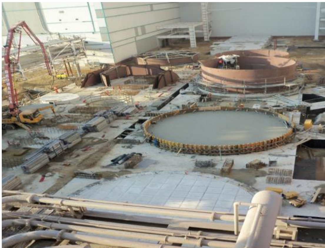
Wykonanie fundamentów dla absorberów, pompowni i innych obiektów
