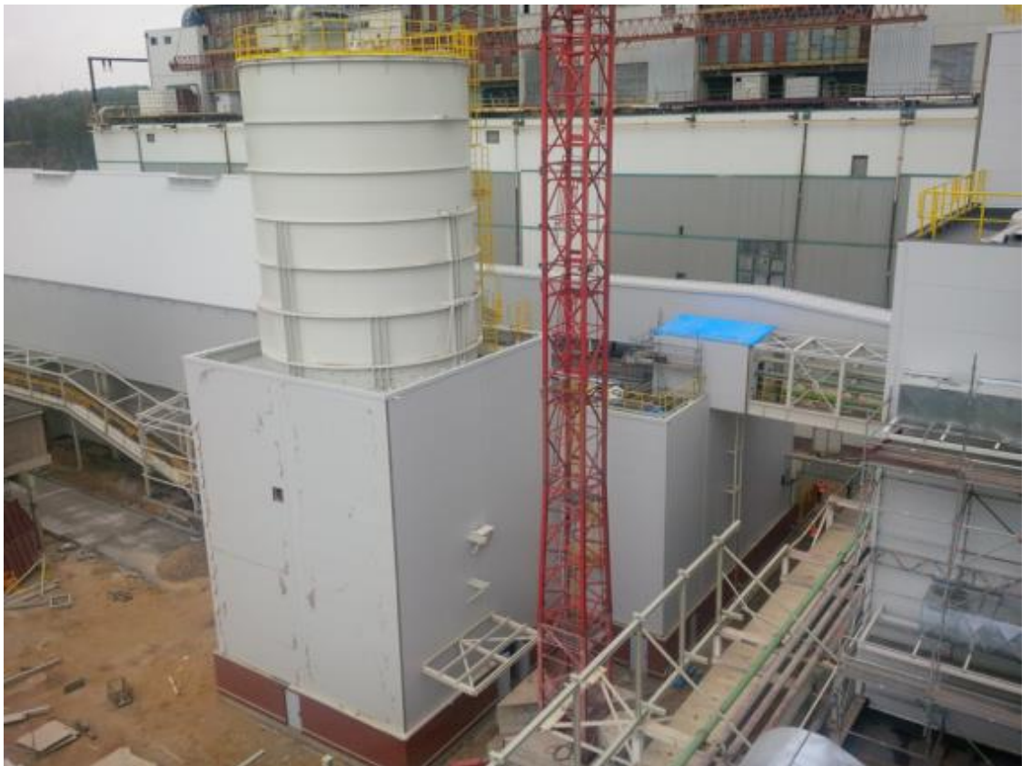
Wykonanie układu oczyszczania ścieków
