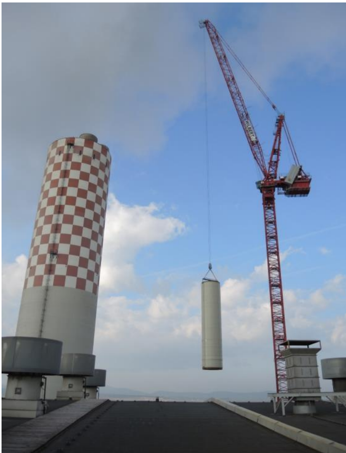
Adaptacja ciągu komina sześcioprzewodowego
