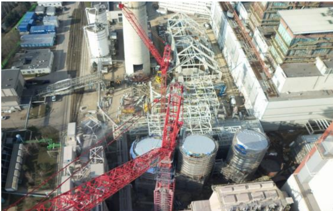
Wykonanie konstrukcji magazynu pryzmowego i urządzeń do odwadniania gipsu
