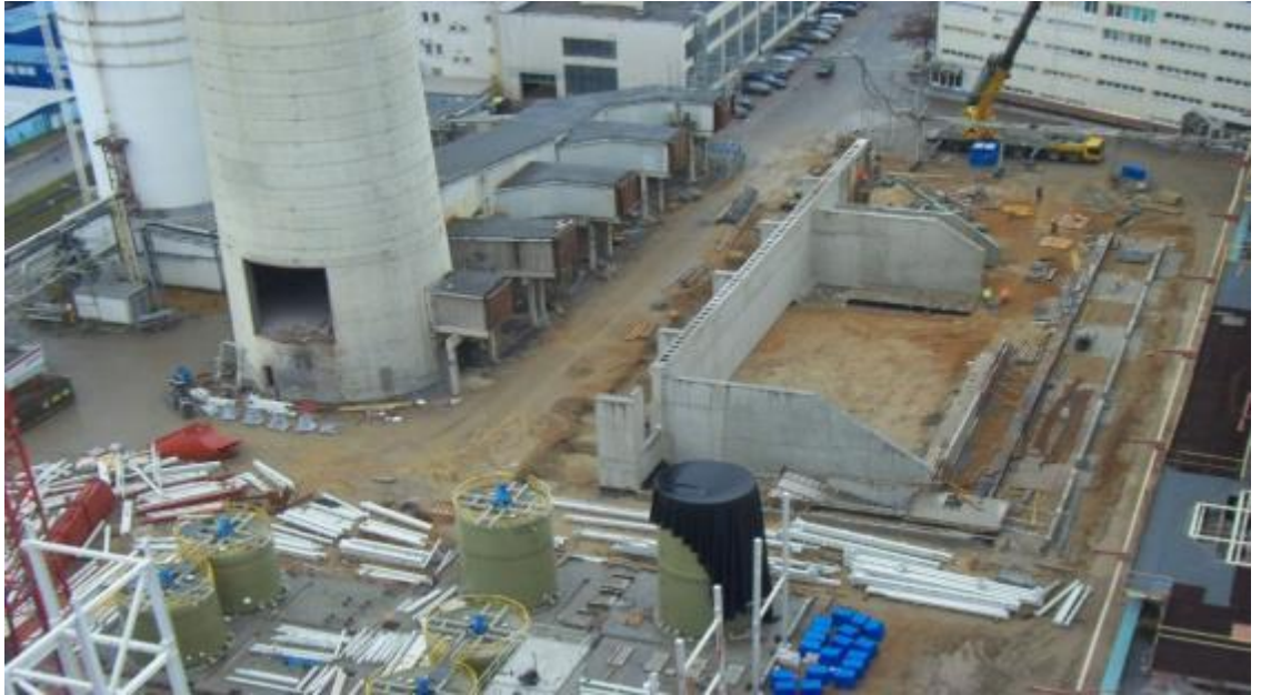
Wykonanie fundamentów dla budynku magazynu pryzmowego
