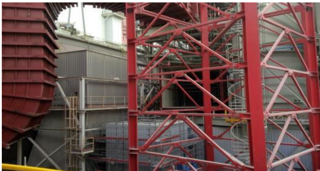
Montaż i rozruch wentylatora spalin dla bloku nr 5
