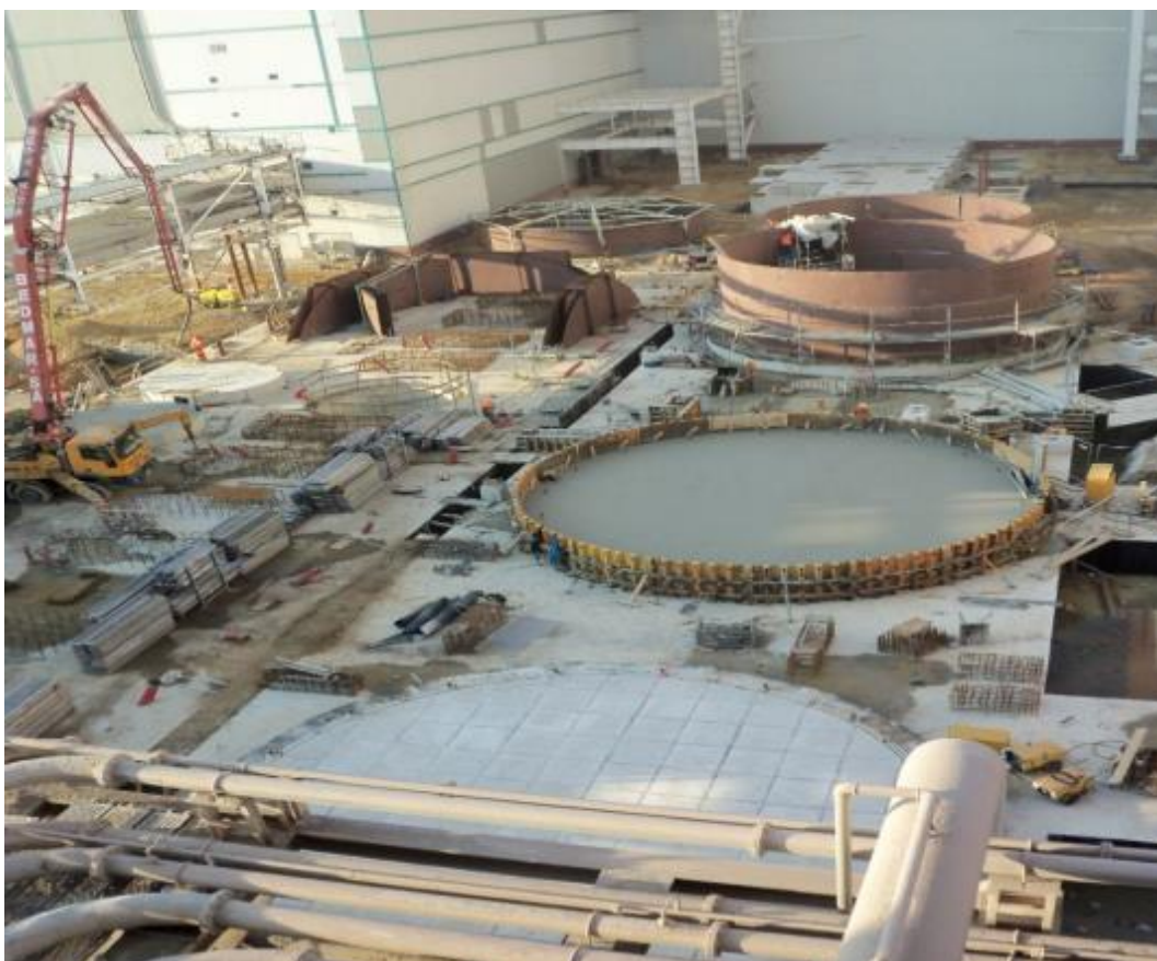
Fundamenty absorberów, pompowni i innych obiektów
